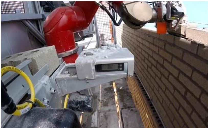
Figuur 4: Metselrobot van Construction Robotics, op de bouwplaats. (bron: internet).
