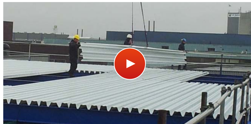
Metalen dakplaat leggen met behulp van de hijskraan
