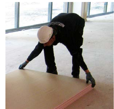
Platen op de grond neerleggen en oppakken
