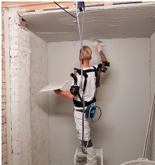
Figuur 6: Stukadoors aan het werk met een armondersteunend exoskelet (Skelex) tijdens het experiment door TNO en Knauf (de Vries e.a., 2020a)
